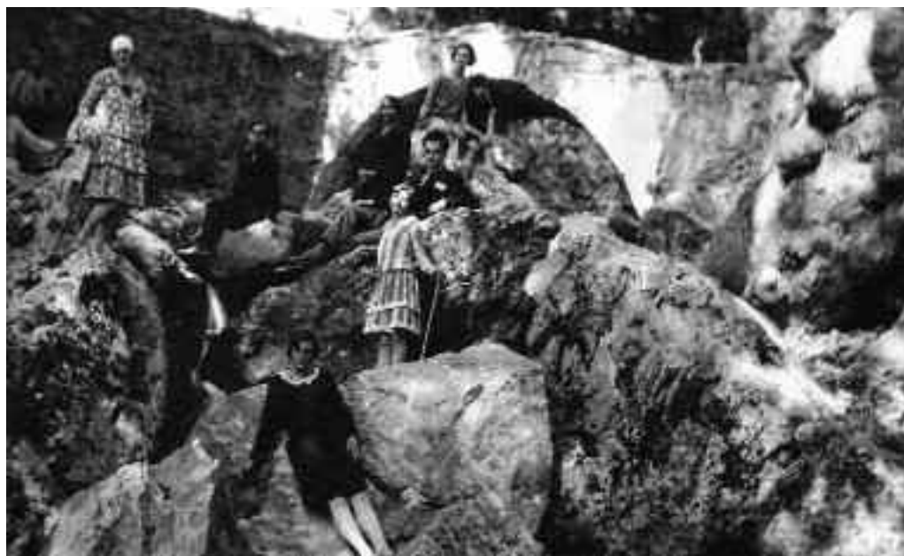
Στο γεφύρι της Αγίας Παρασκευής στο Ανήλιο. (Αρχείο Ευαγγελίας Βλαχοστέργιου).
